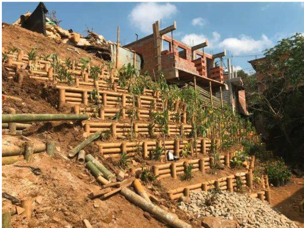
Ilustración 7 Ejemplo de implantación de obras de bioingeniería tipo estabilización viva con trinchos de guadua.
